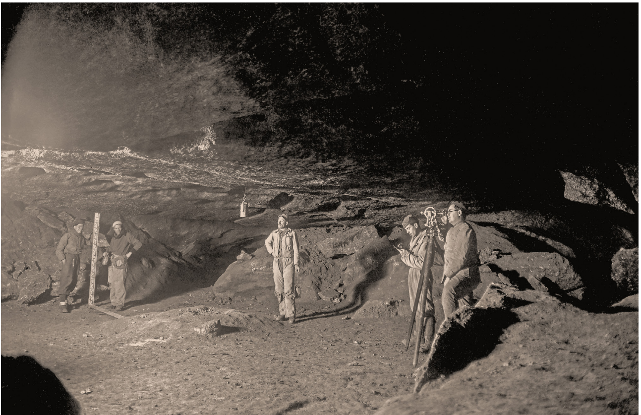
Dicembre 1936: Grotta del Farneto (Gessi bolognesi), Sala del Trono: il rilevamento topografico del piano superiore della cavità (foto L. Fantini - Archivio GSB-USB).
