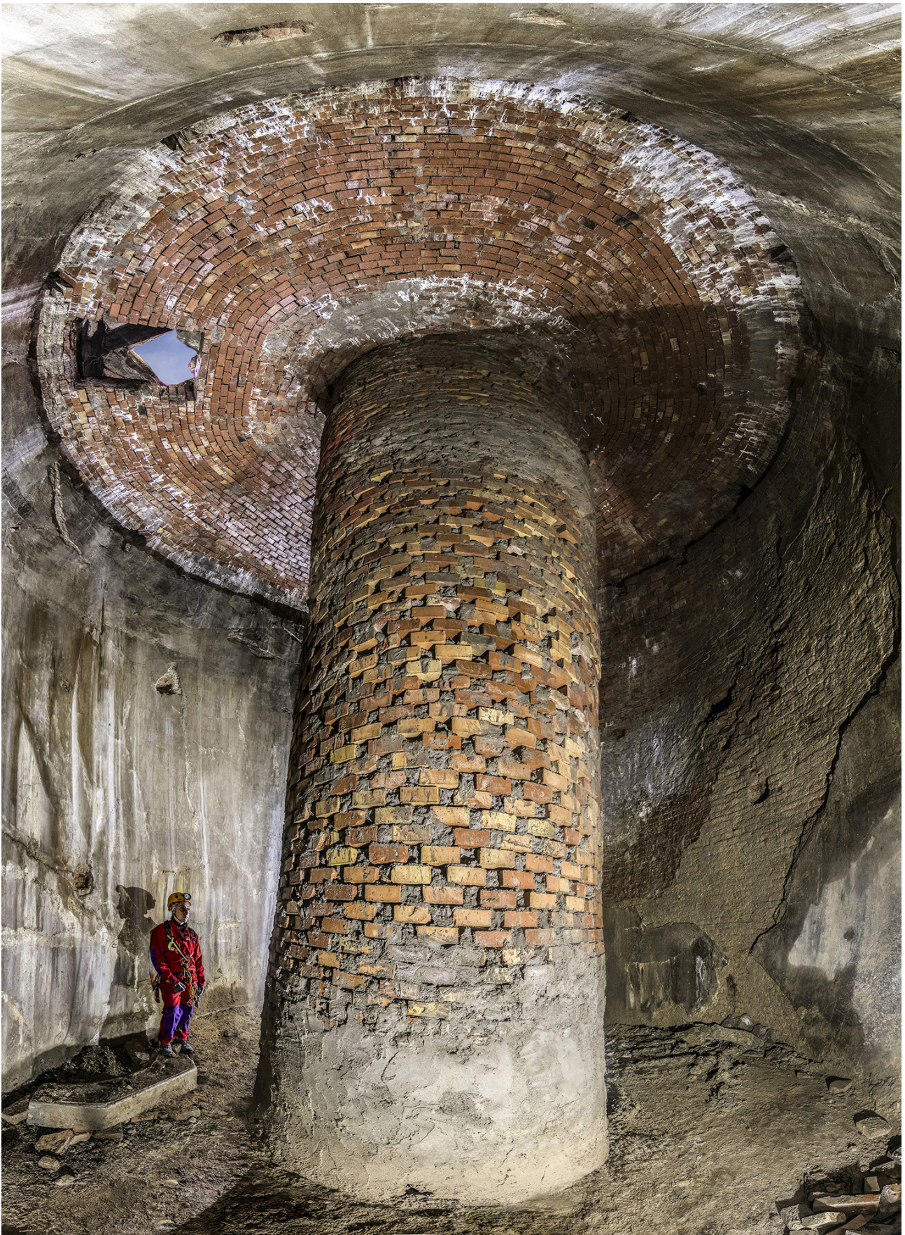
Fig. 6 – Interno della cisterna pubblica borromeiana di Tossignano (Borgo Tossignano, Vena del Gesso romagnola), realizzata nella sua configurazione originaria tra 1560 e 1565 e posta al di sotto dell'odierna piazza Andrea Costa (foto P. Lucci). La "canna" laterizia centrale (già presente nella versione originaria della struttura) e parte della volta sommitale sono state ricostruite dopo le distruzioni della Seconda Guerra Mondiale (da PIASTRA 2022a).
