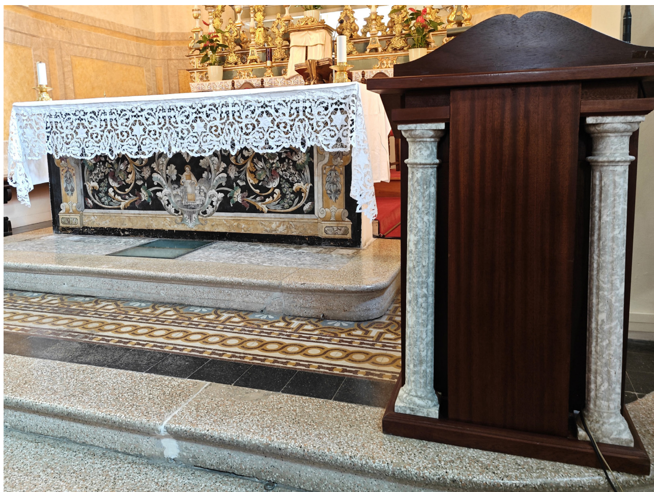
Fig. 4 – Paliotto d'altare in scagliola policroma e colonnine in alabastro. Due lastre di alabastro sono presenti di fronte al paliotto. Chiesa di San Lorenzo, Talamello (Rimini) (foto S. Lugli).
