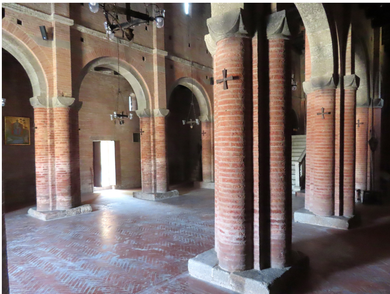
Fig. 2 – Blocchi di selenite nei basamenti di pilastri, capitelli cubici, archi a tutto sesto, cornici sopra agli archi e tra gli archi nella Pieve di Santa Maria Annunziata e San Biagio, Sala Bolognese (foto S. Lugli).
