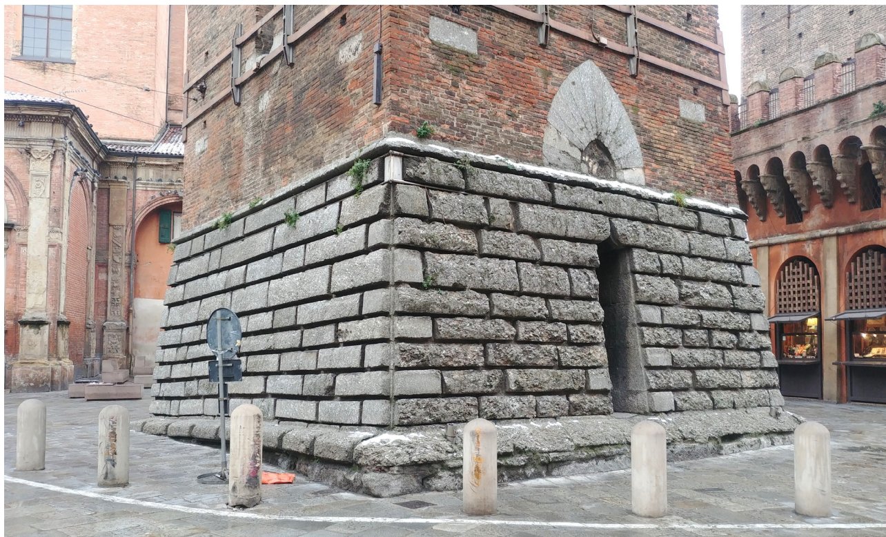
Fig. 1 – Grandi blocchi di selenite nel basamento della torre Garisenda a Bologna, come appariva prima degli interventi di consolidamento. Notare la diversa intensità del degrado nelle facciate. Alcune parti hanno anche subito in passato interventi di sostituzione e di rimozione delle porzioni degradate per scalpellatura. Blocchi di gesso sono presenti anche al di sotto del loggiato della torre degli Asinelli (a destra) (foto S. Lugli).
