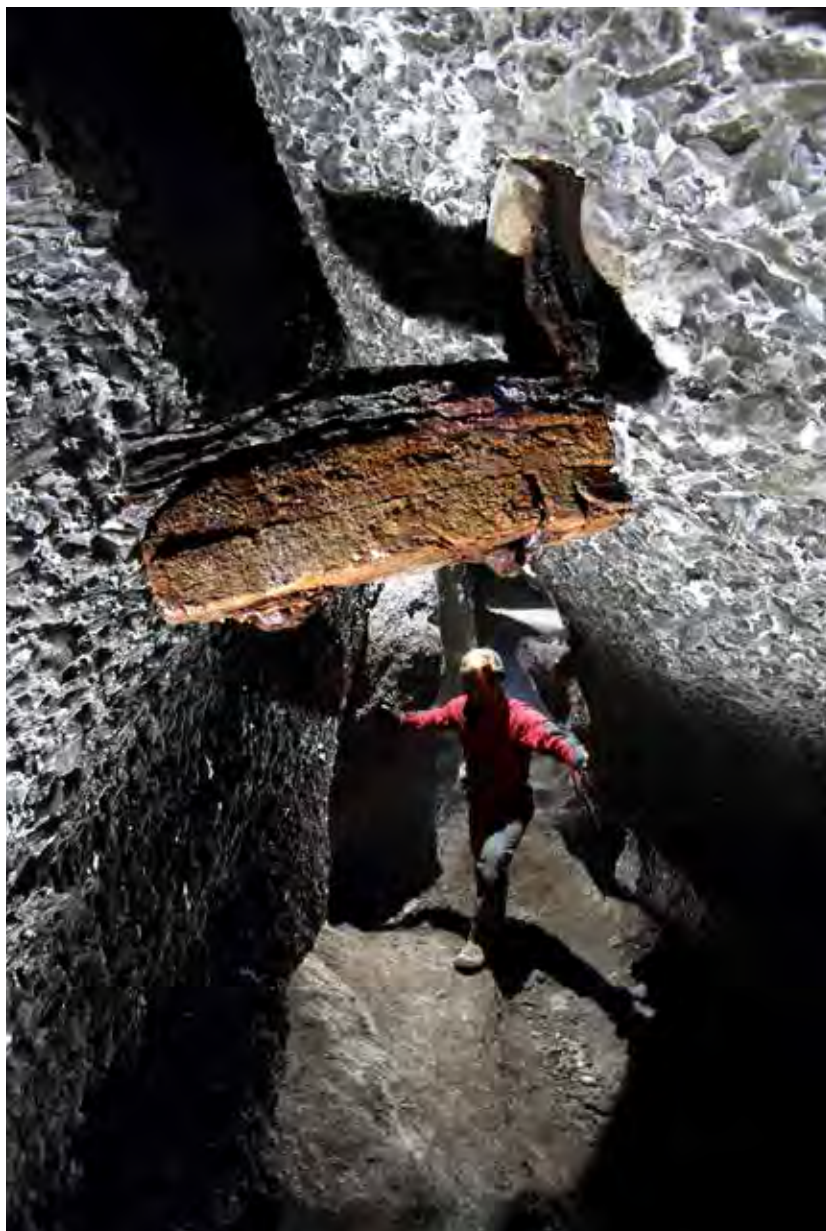
Fig. 6 – San Lazzaro di Savena (BO), Risorgente dell'Acquafredda. Un isolatore che supportava i cavi provenienti dalla cabina elettrica della cava ancora presente nella grotta (foto F.Grazioli).
