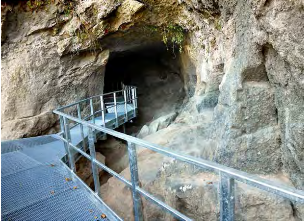
Fig. 1 – Riolo Terme (RA), Grotta del Re Tiberio. Interventi di valorizzazione 2013-2014. Veduta dell'ingresso dall'esterno, con ballatoio e rampa pedonale (Archivio SABAP-BO).
