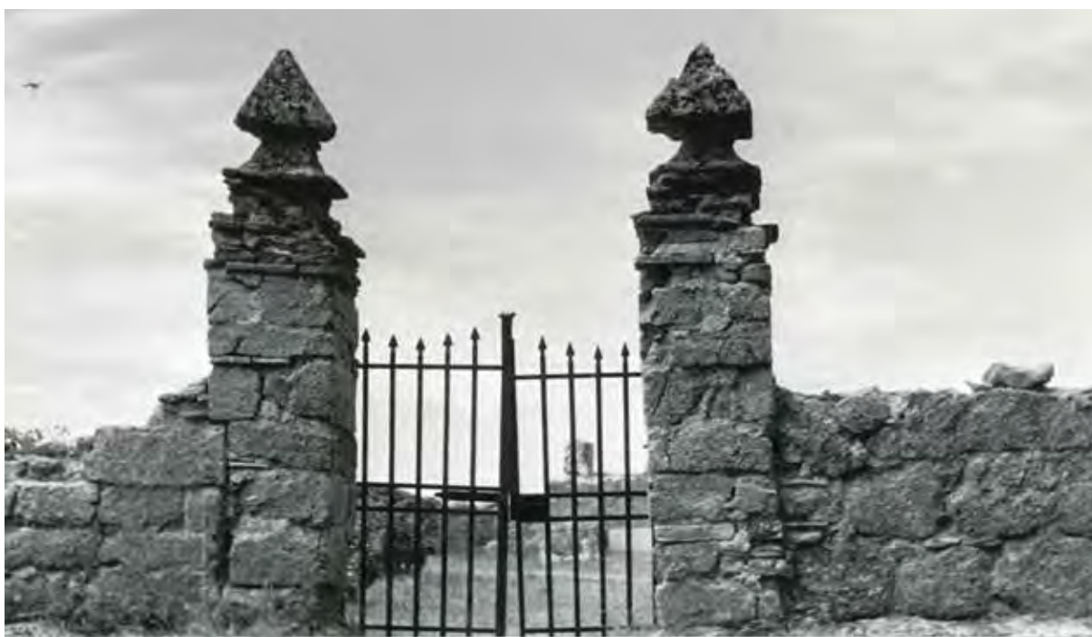
Fig. 52 – Brisighella (RA), il cimitero presso la Pieve di Monte Mauro nel 1958 (foto arch. GSFa).
