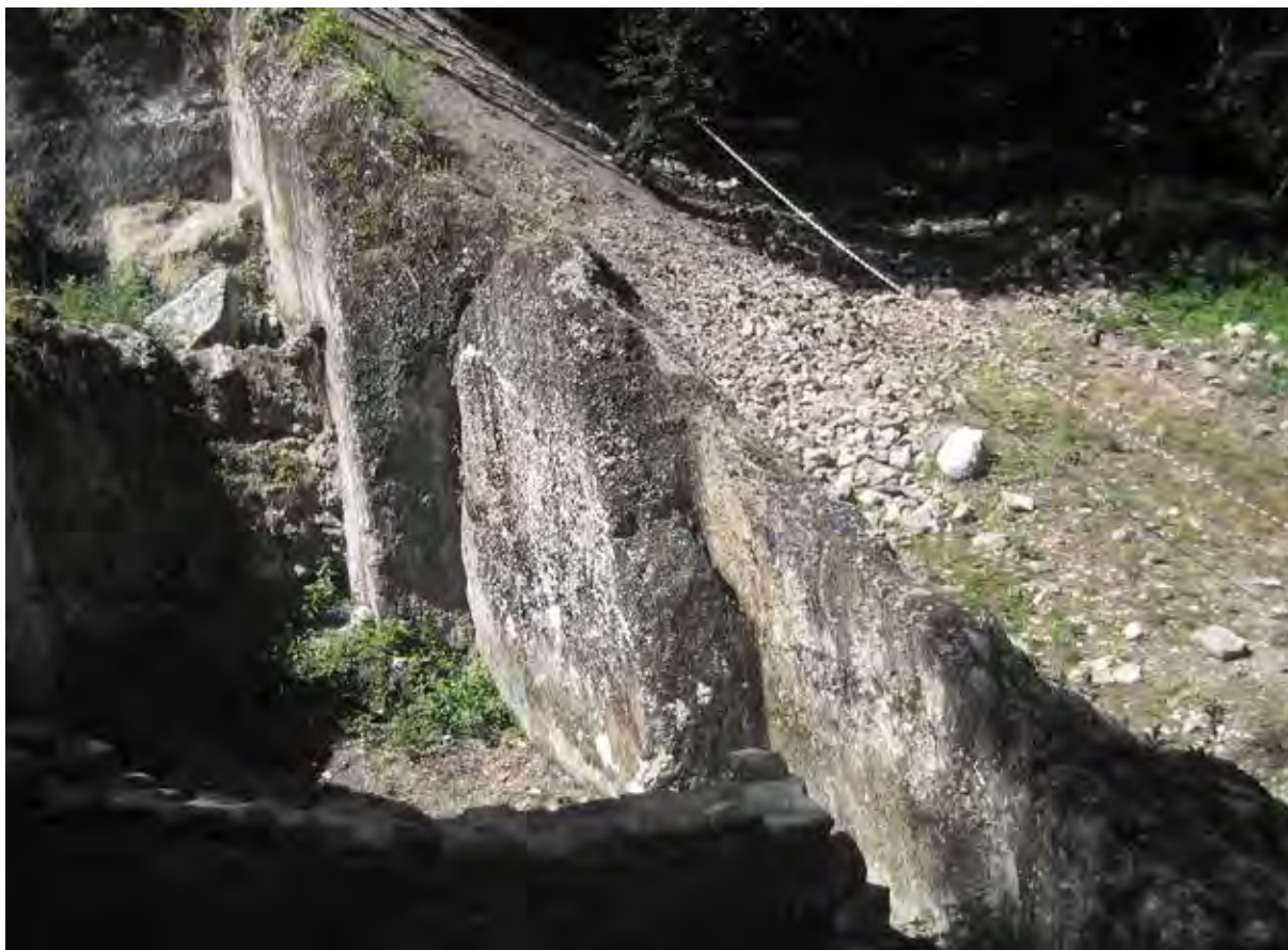
Fig. 11 – Albinea (RE), rupe del Castello di Borzano. Veduta del fronte settentrionale della cava (foto degli autori – Archivio SABAP-BO).
