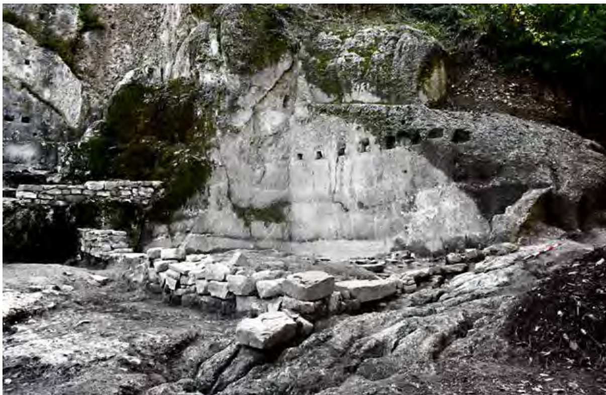
Fig. 14 – Albinea (RE), rupe del Castello di Borzano. Allineamento di fori per le travi del solaio ricavate in una parete della cava (foto degli autori – Archivio SABAP-BO).
