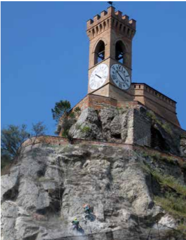
Fig. 19 – Colle della Torre dell'Orologio: disgaggio dei massi gessosi pericolanti (2008) (foto S. Piastra).
