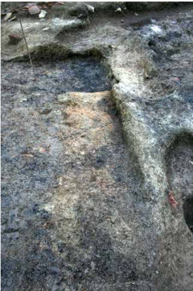
Fig. 7 – P. I, Edificio 1. I gradini US 132 e 143 realizzati in pani d'argilla che mettevano in comunicazione gli ambienti 1 e 2.
