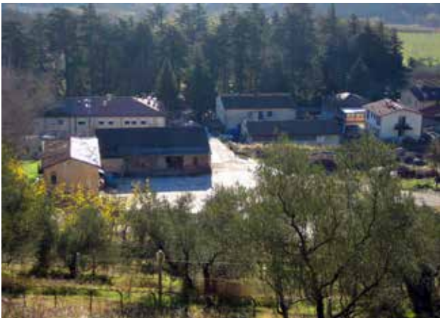
Fig. 62 – L'ex area del "Molinone" nel 2009, mentre erano in corso i lavori per la riconversione funzionale dell'area (foto S. Piastra).
