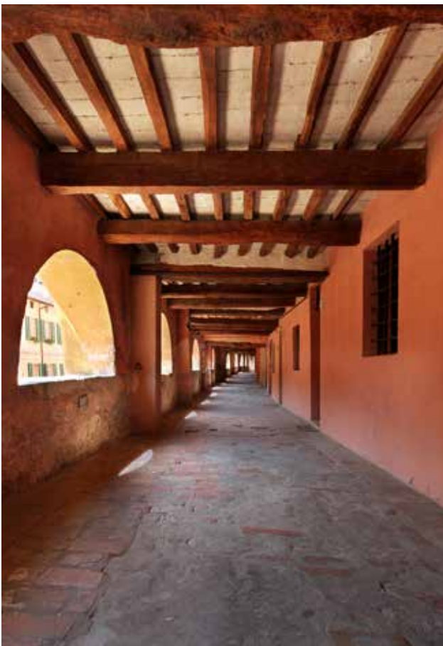
Fig. 16 – L’interno della “via degli Asini” (foto P. Lucci).
