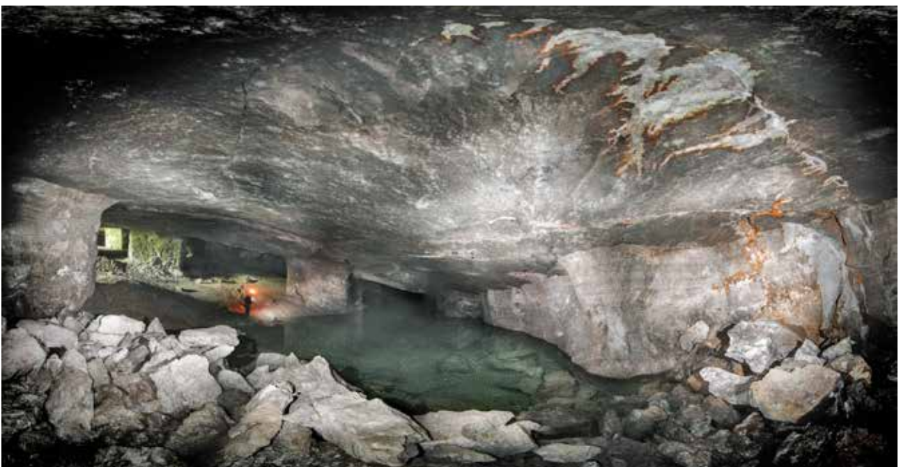
Fig. 71 – L'interno delle gallerie nord-occidentali della cava Marana, le quali oggi ospitano un laghetto artificiale formatosi successivamente alla dismissione del sito (foto P. Lucci).
