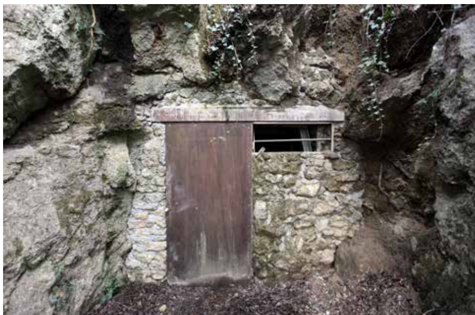
Fig. 6 – La chiusura realizzata all'imbocco artificiale della Tanaccia (Archivio Life+ 08/NAT/IT/369 "Gypsum"; foto F. Grazioli).
