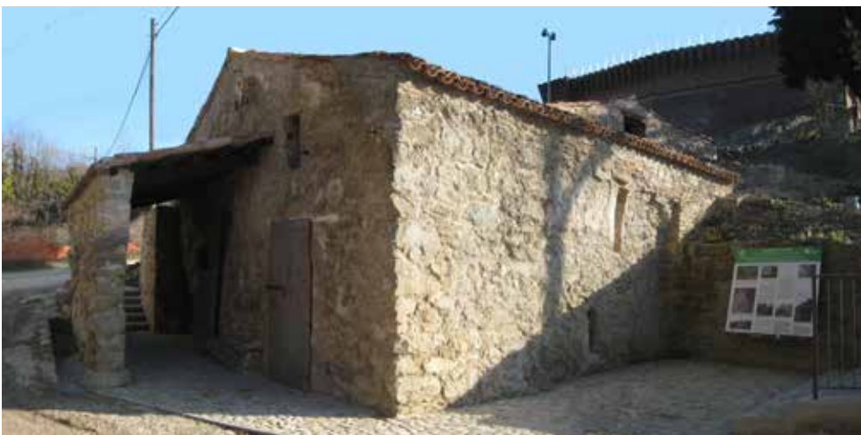
Fig. 3 (a destra) – Fornace Malpezzi: il cantiere di restauro e consolidamento strutturale. Dicembre 2010 (foto T. Conti, S. Galegati).
