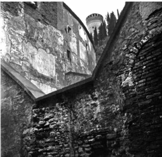
Fig. 37 – ARCHIVIO FOTOGRAFICO DELLA ROMAGNA DI PIETRO ZANGHERI – Patrimonio pubblico della Provincia di Forlì-Cesena, in gestione al Parco Nazionale delle Foreste Casentinesi. Scatto di Pietro Zangheri; foto 820 del 1938. Briglia a salto doppio, in cemento, realizzata in corrispondenza del sito di una casa di via Spada crollata in precedenza e funzionale a drenare alcune venute d’acqua. Il muro dell’edificio visibile sulla sinistra appartiene a Palazzo Spada, in parte crollato nel 1964 e successivamente completamente demolito.
