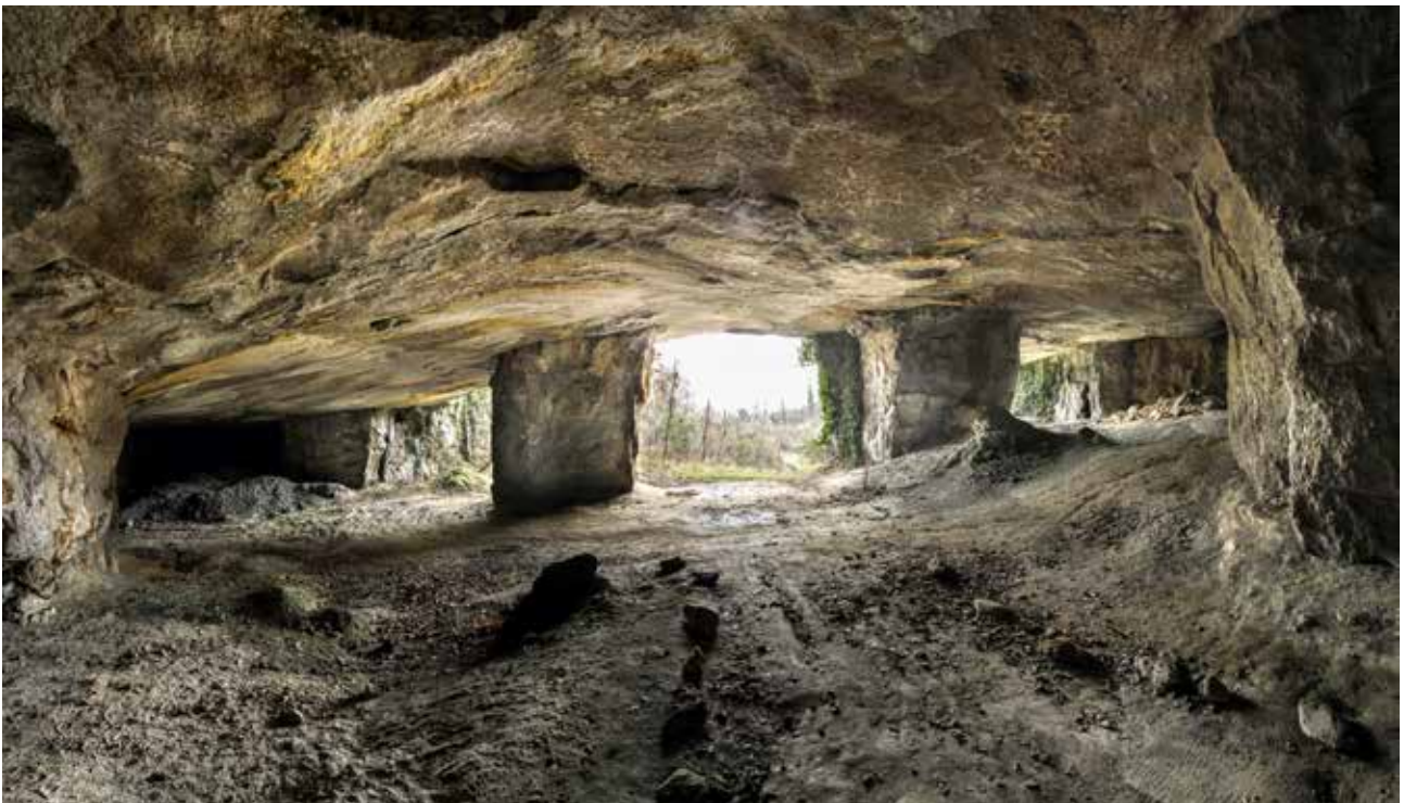
Fig. 69 – Le gallerie del lato nord-occidentale della cava Marana: prospettiva dall'interno verso l'esterno (foto P. Lucchi). La coltivazione in sotterraneo, sviluppata su un solo livello, segue qui il tradizionale metodo "camere e pilastri", demolendo un singolo bancone gessoso, di potenza considerevole e appartenente ai cicli inferiori della successione evaporitica.
