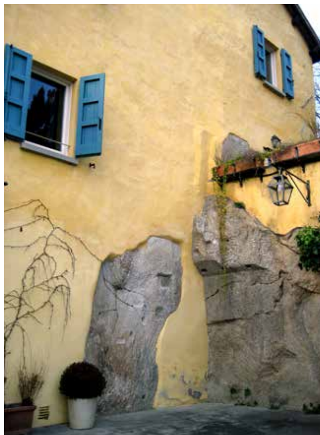
Fig. 3 – Via del Trebbio, Brisighella. Edificio ancorato posteriormente al substrato gessoso, opportunamente sagomato artificialmente (foto S. Piastra).
