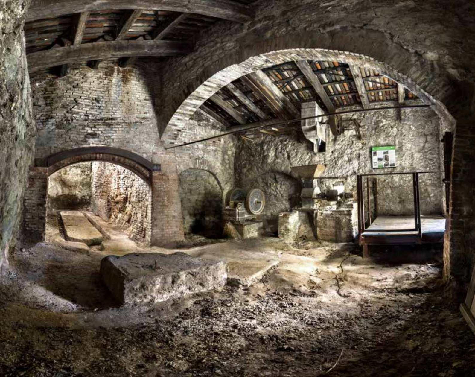
Fig. 5 – L'interno della fornace Malpezzi successivamente al restauro (foto P. Lucci).
