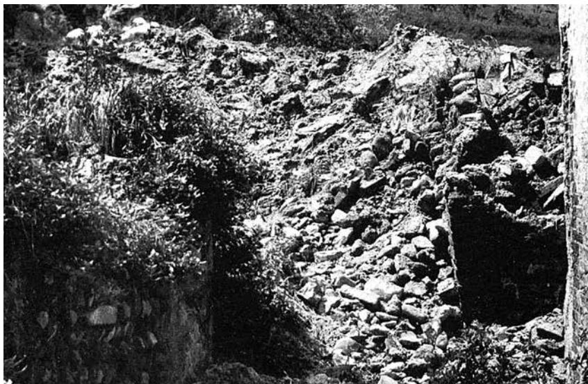
Fig. 21 – Frana del 1939 nella valle cieca del Rio della Valle, la quale distrusse alcune abitazioni alle spalle del Municipio e fu alla base di ulteriori sventramenti nell'area (da AA.Vv. 1999).
