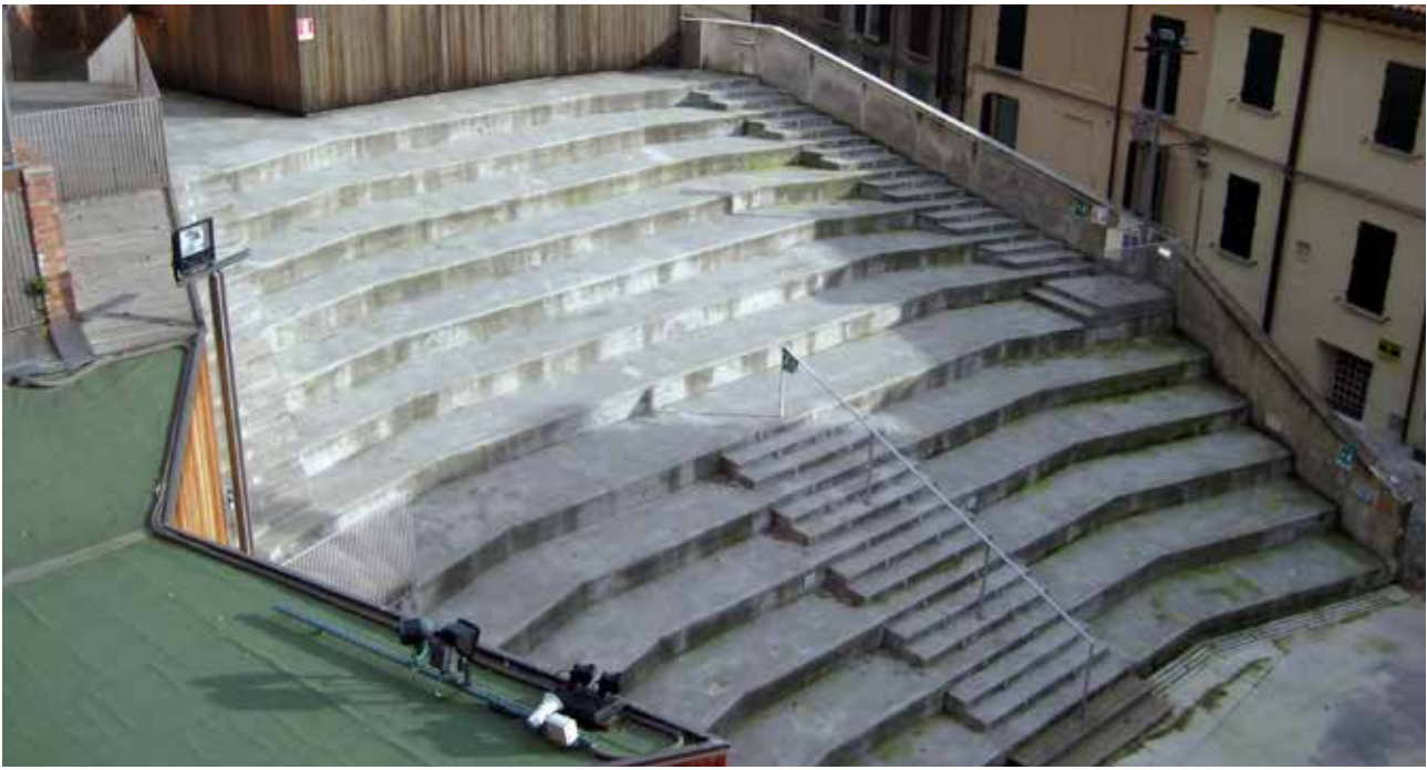
Fig. 40 – Il teatro all’aperto di via Spada, realizzato alla metà degli anni ‘80 del Novecento in corrispondenza del sito dove era ubicato Palazzo Spada, crollato parzialmente nel 1964 e successivamente abbattuto. La struttura appare molto discutibile sotto il profilo della sua pertinenza e integrazione all’interno del paesaggio urbano brisighellese (foto S. Piastra).
