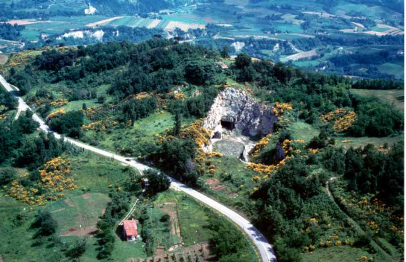
Fig. 68 – ARCHIVIO Luciano BENTINI. Foto aerea della cava Marana risalente alla fine degli anni '80- primi anni '90 del Novecento: sono visibili gli affacci delle gallerie che si aprono sul lato meridionale del piazzale, oggi in condizioni statiche precarie. In quegli anni il sito estrattivo spiccava ancora nel paesaggio locale; oggi esso risulta invece semi-nascosto dalla vegetazione.
